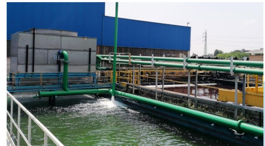
apposite vasche di raccolta per essere inviate agli impianti di depurazione (uno per l'acciaieria e uno per il laminatoio), dotati di vasche di decantazione e di filtri a sabbia.
